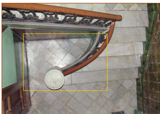
Vista en picat del primer tram de l'escala. En la imatge s'ha indicat en groc l'espai on es va realitzar el sondeig
